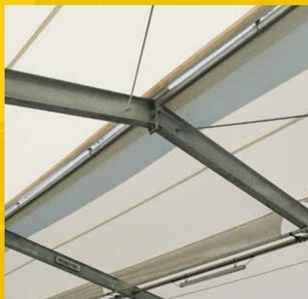
Конструкция на покрива на Cosyhome Calf Village
