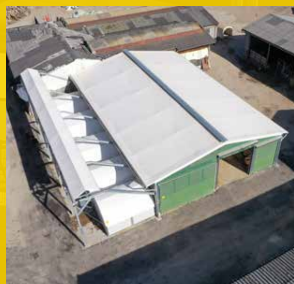
Допълнителна светлина благодарение на белия покрив
