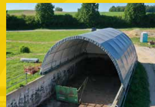
Навес поставен върху помещение за съхранение на оборски тор
