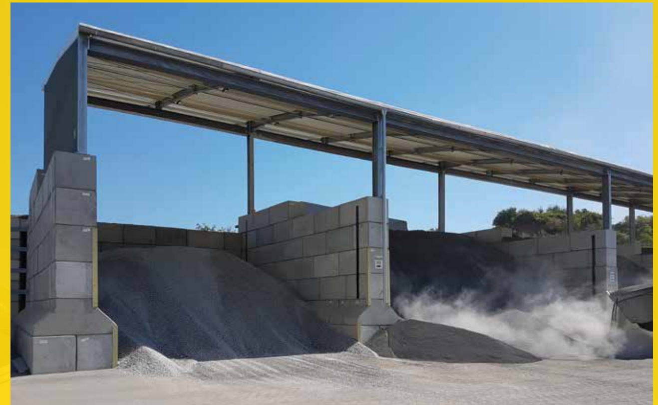
Сенник със станция за пълнене и изпразване
