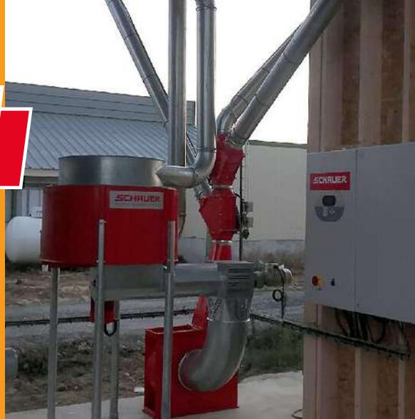
Трансферен модул със смукателна тръба и превключвател
