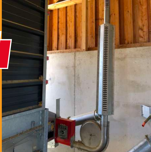
Система за почистване на филтъра
